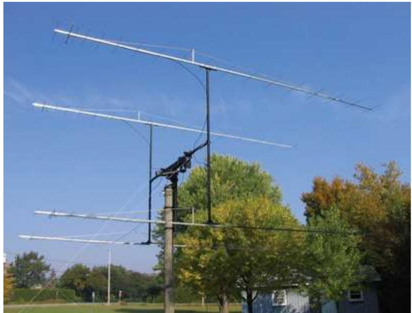
Figure. un réseau de 4 Yagis de 18 éléments à un kilowatt
