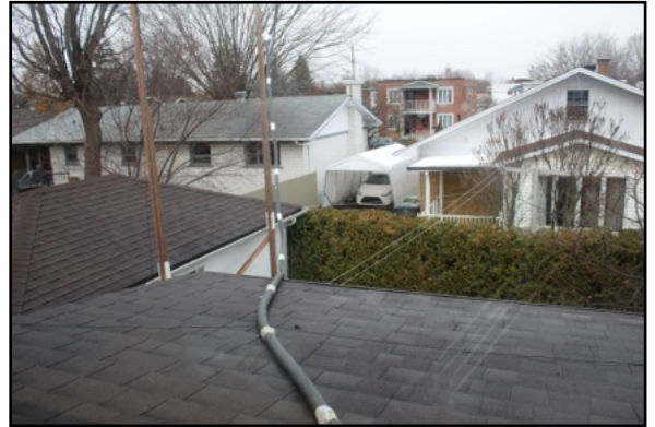
Figure 1: Ligne de transmission a la John Portune
